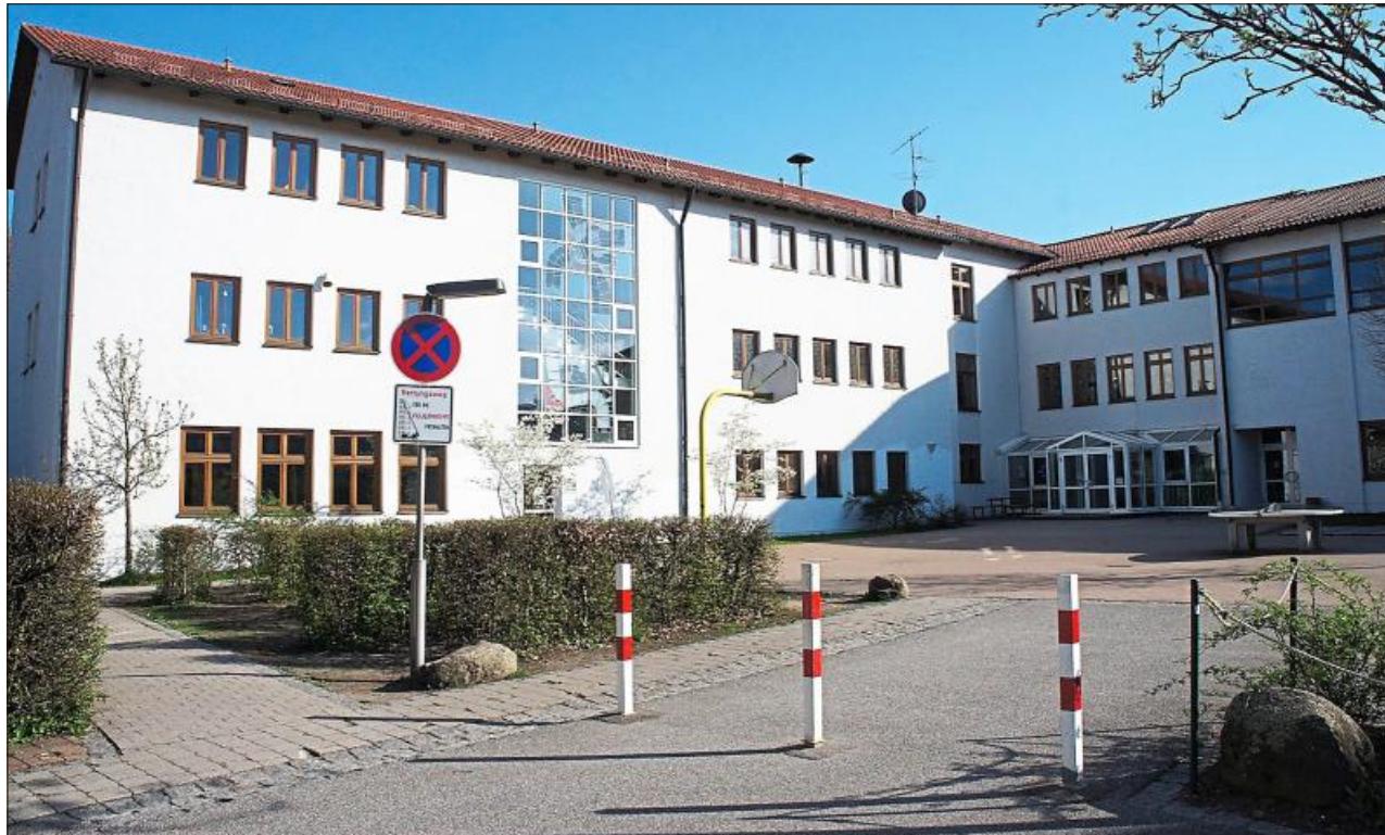
Die Öl-Heizung der Grundschule wird im August durch eine mit Holzpellets ersetzt.
